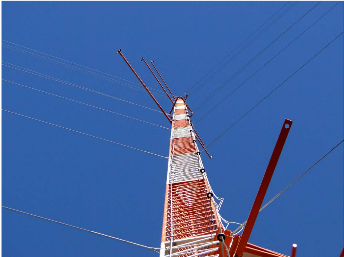
Figura 17: Torre anemométrica com equipamentos em três diferentes alturas. Fonte: Sequoia Energia.
